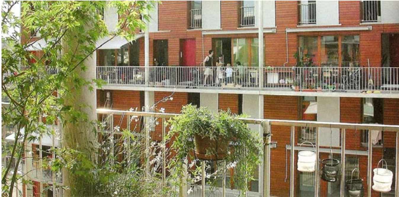
Habitat groupé en coopérative, l'habitat MILL'O, Suisse.
