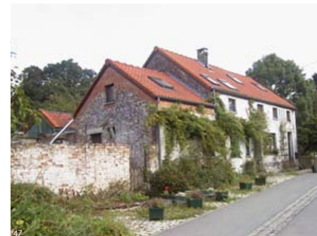
Maisons destinées à la démolition en 1969
