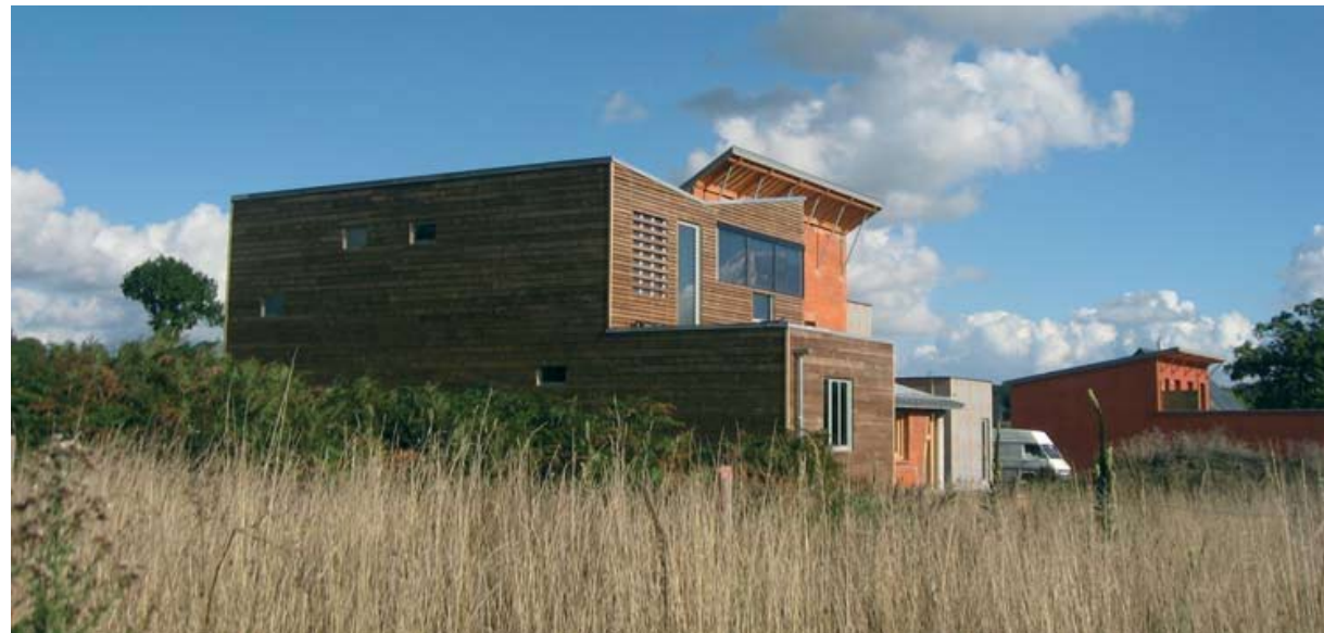
Un bâtiment écologique à Bazouge sous hédé
